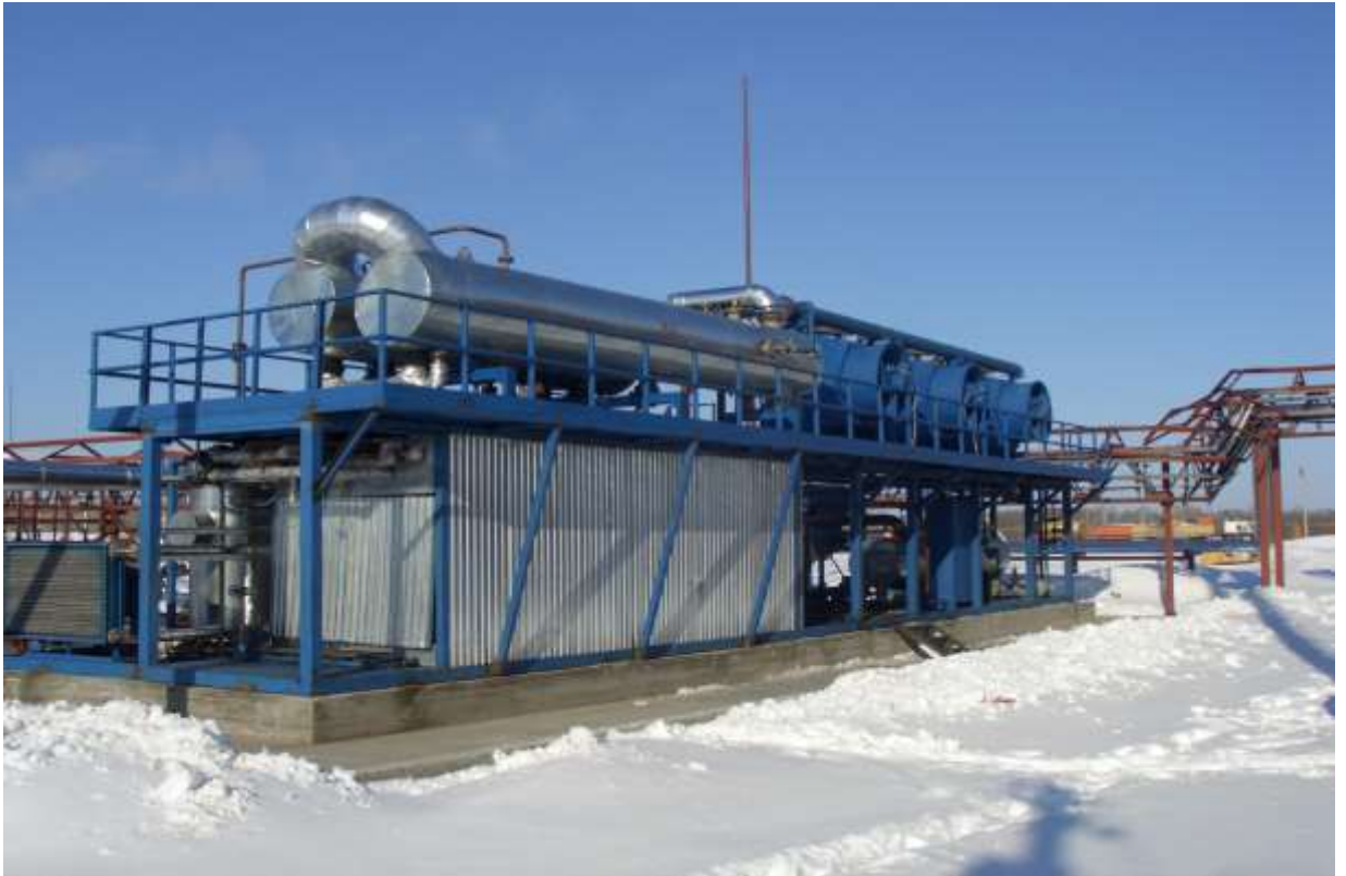
Фотография на обьекте (модуль ректификации Б-1)
