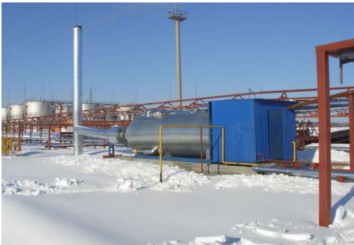
Фотография на объекте (модуль подогревателя П-1)
